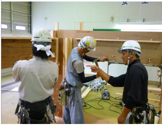
型枠施工作業
