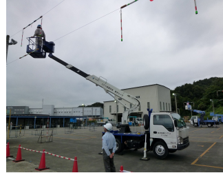
高所作業車運転 技能講習
