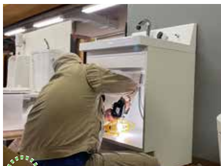
衛生器具の取付け
