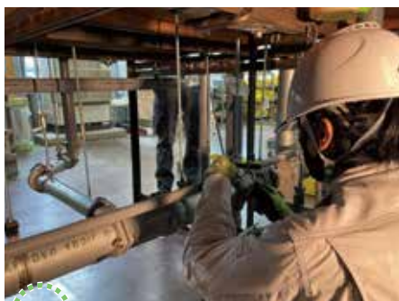
給排水配管の施工
