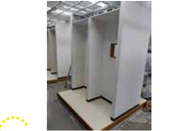
模擬家屋の施工（基礎）
