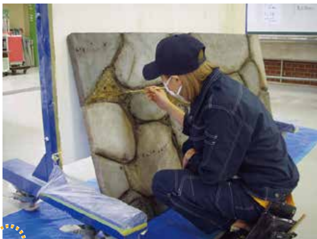
デコラティブペイント作業(石垣風塗装)
