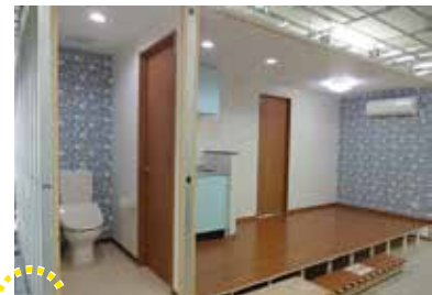
模擬家屋の施工（応用実習）
