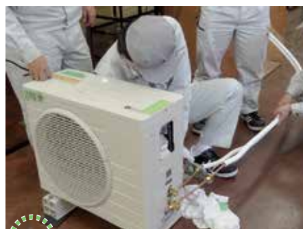
エアコンの取付け
