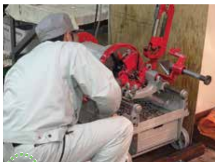
給排水配管の施工
