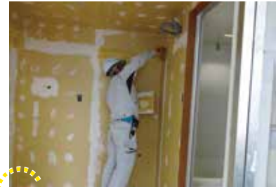
壁の下地処理（パテ処理）
