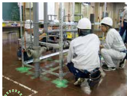
給排水配管の施工
