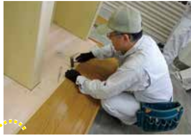
フローリング施工
