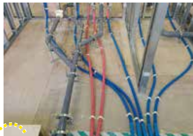
建築設備（配管の施工）
