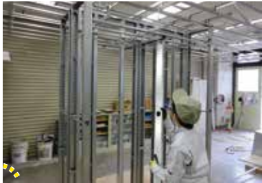
鋼製下地（壁と天井の下地）
