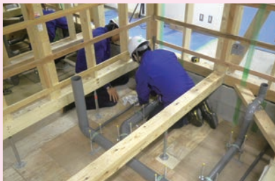
給排水配管作業
