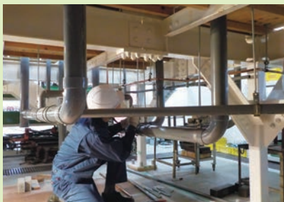
パイプ接続の実習
