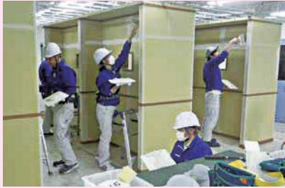
クロス張り下地処理作業
